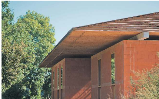
Les ateliers bermuda en plein chantier. GUILLAUME ROBERT, 2021
